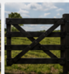
PORTEIRAS E ESTRUTURAS
